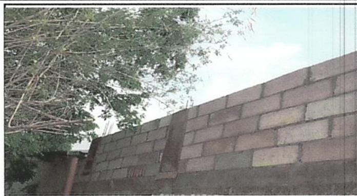
Foto 2: El muro perimetral se reparó por las malas condiciones y altura del mismo y expuesto a las instalaciones del establecimiento.
