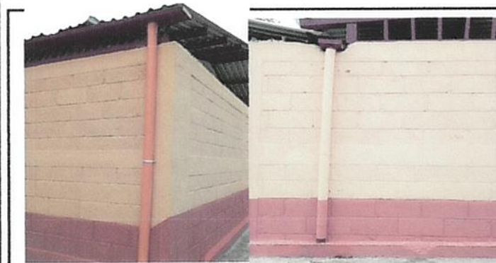
Foto 11: Las bajas de agua pluvial se cambiaron debido al mal estado en que se encontraban y para evitar humedad en las paredes por motivos de las lluvias
