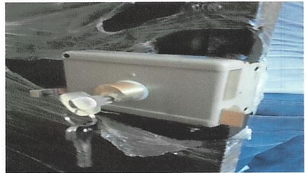
Foto 10: La sustitución de la chapa a puerta de metal se realizó debido a que la otra se encontraba en mal estado
