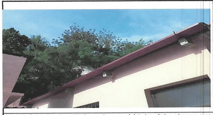
Foto 12: Se realizó el cambio de canales pero el deterioro de los mismos y para un mejor flujo del agua pluvial
