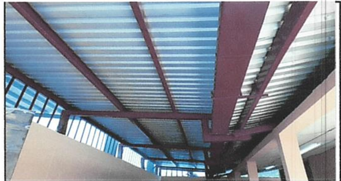
Foto 8: La estructura del soporte de metal se instaló considerando que esta encontraba en malas condiciones debido al deterioro de la misma
