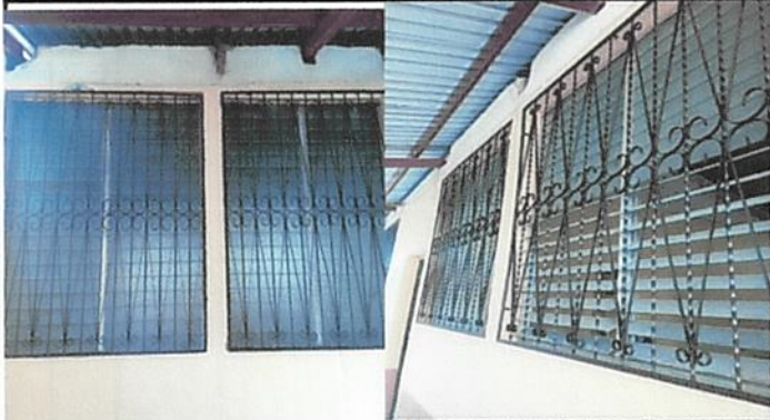
Foto 13: Se le dio mantenimiento de pintura a los balcones los cuales ya estaban deteriorados
