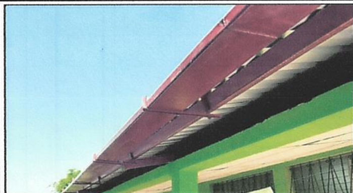
Foto 1: Los canales se sustituyeron para que el fluido del agua pluvial no afecte por la humedad
