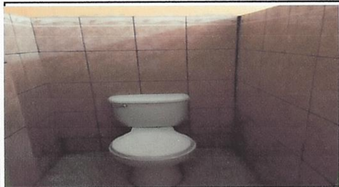
Foto 9: La sustitución de azulejo se realizó con la finalidad de brindar un ambiente de higiene en los servicios sanitarios
